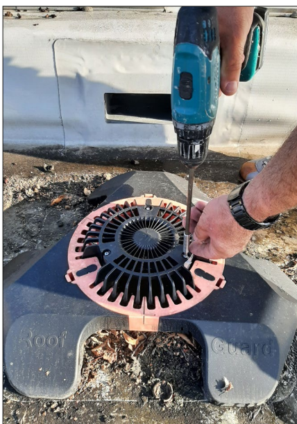
Bild 3: Die fünf ROOFGUARD-Laubsiebe wurden zunächst ohne FLECK connect montiert - die Nachrüstung, die nur weniger Handgriffe bedarf, fand zu einem späteren Zeitpunkt statt.
