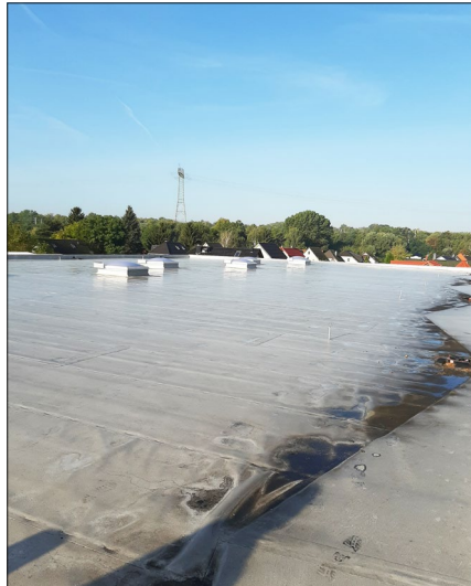
Bild 1: Das Flachdach des Lagers der Dachdecker-Einkauf Ost eG in Berlin-Biesdorf hat insgesamt eine Fläche von 40 x 20 Meter.
