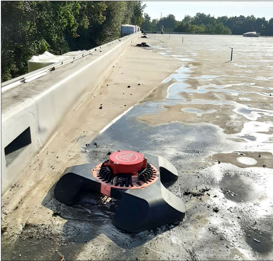
Bild 6: Dank der ROOFGUARDS mit FLECK connect muss die Dachdecker-Einkauf Ost eG nun keine verstopften Gullys aufgrund der umliegenden Laubbäume befürchten.
