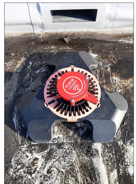
Bild 5: Nachdem die Verbindung hergestellt wurde, wurde das FLECK connect-Gehäuse mithilfe der vorhandenen Schrauben des ROOFGUARDs bzw. der mitgelieferten zusätzlichen Schrauben befestigt und wetterfest verschlossen.
